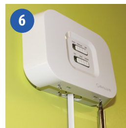
Zajistěte přední stranu přijímače šrouby.
